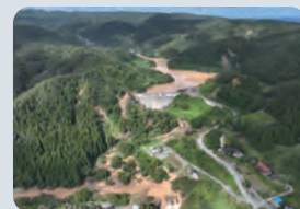
能登町北河内ダム周辺
