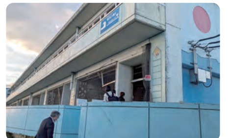
震災遺構・浪江町立請戸小学校
