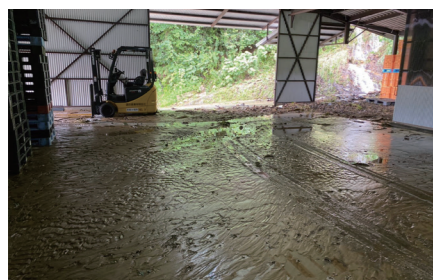
※天草ジュース出荷組合 被害の様子
