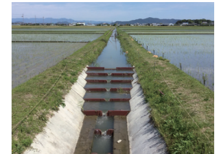
「堰上げ式魚道」排水路に堰板を設置し、水位を階段状に10cmづつ上げて田んぼとの落差を解消し、上流域のすべての田んぼに上れる仕組み。
