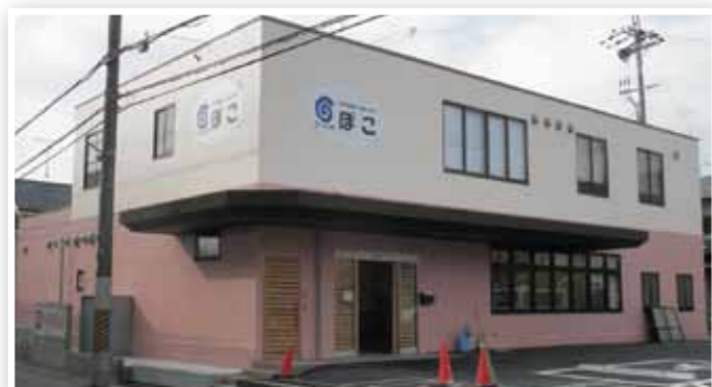
春のオープンに向けて、ただ今建設中!
