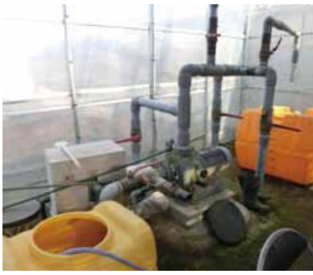
深井戸ポンプで地下40mの水をくみ上げています
