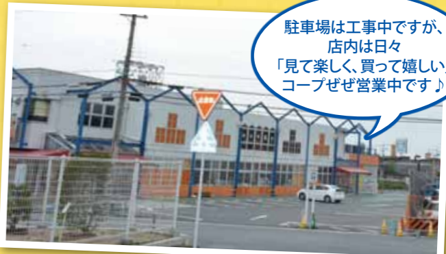
現在、工事に伴い駐車場を縮小しております
