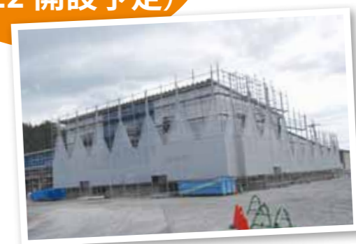
建設中の東近江センター
