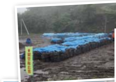
飯館村: 除染作業を確認
