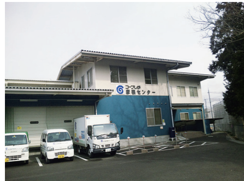
彦根センター 太陽光パネル(屋根)
