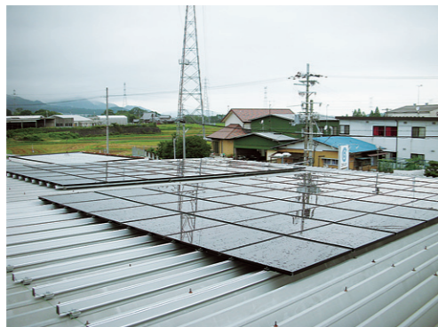
甲南センター太陽光パネル
